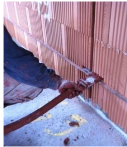
Fig. 3: realiseren verticale voegen
